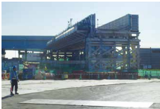
完成へ向けて工事が進む外環道「京葉ジャンクション」
