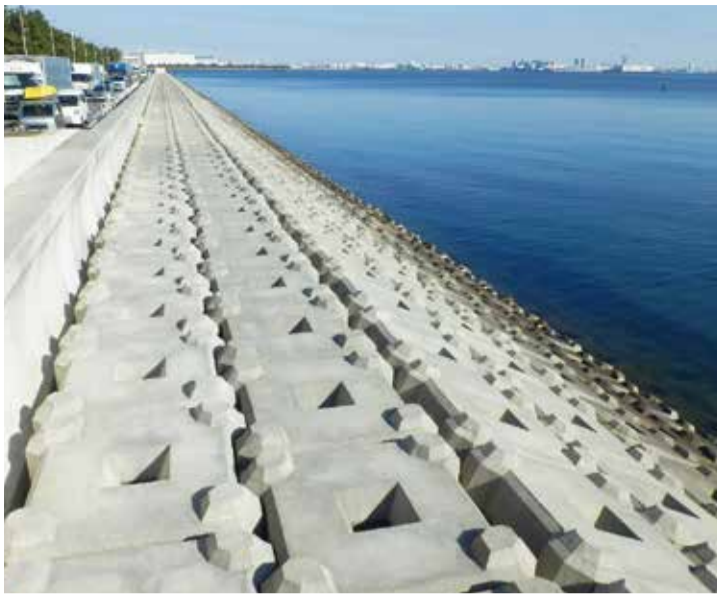
整備された傾斜護岸。前面海域の干潟化が望まれる
