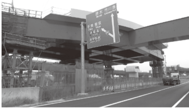
建設が進む外環道の湾岸線結合部分
