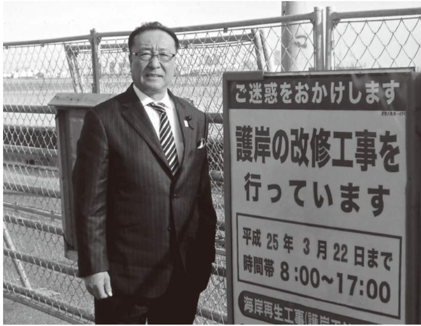
市川市内の三番瀬護岸 改修工事現場
